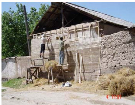
на фото: теплоизоляция дома в Варзобе
